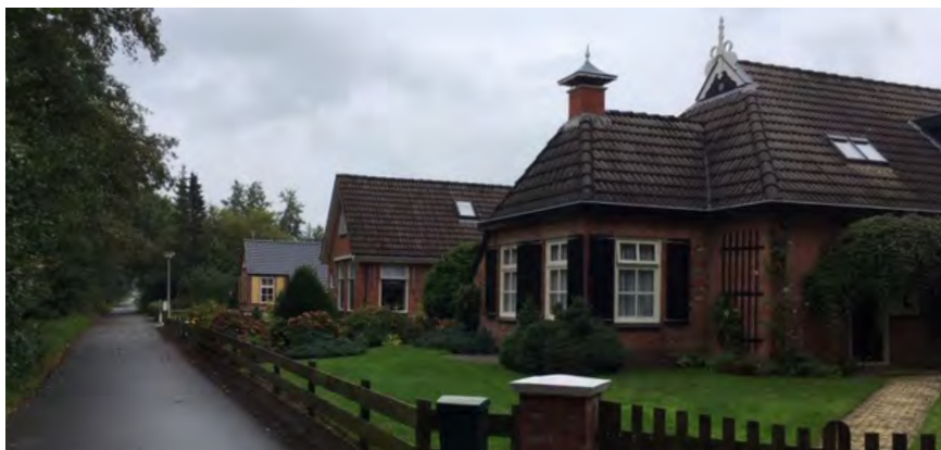
Lintbebouwing aan het Fermanjepaad: de woningen staan vooraan op de kavels en de voortuinen hebben een representatieve uitstraling.
