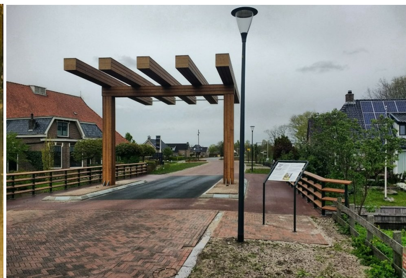
Foto: nieuwe situatie brug Falomsterfeart
