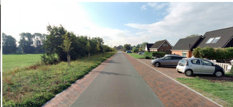
Foto: nieuwe situatie rijbaan Haadwei
