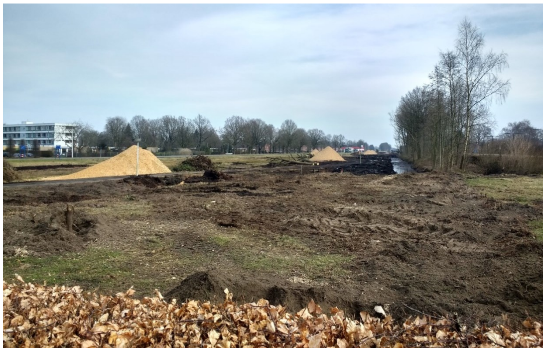
Foto: locatie ter hoogte treinstation na verwijderen bomen
