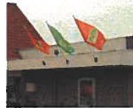
Vlaggestokken aan gevel / luifelrand
