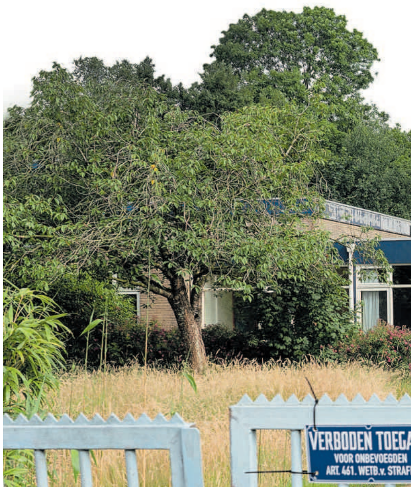
Het voormalige dagbestedingscentrum de Woudhof in Damwâld.
