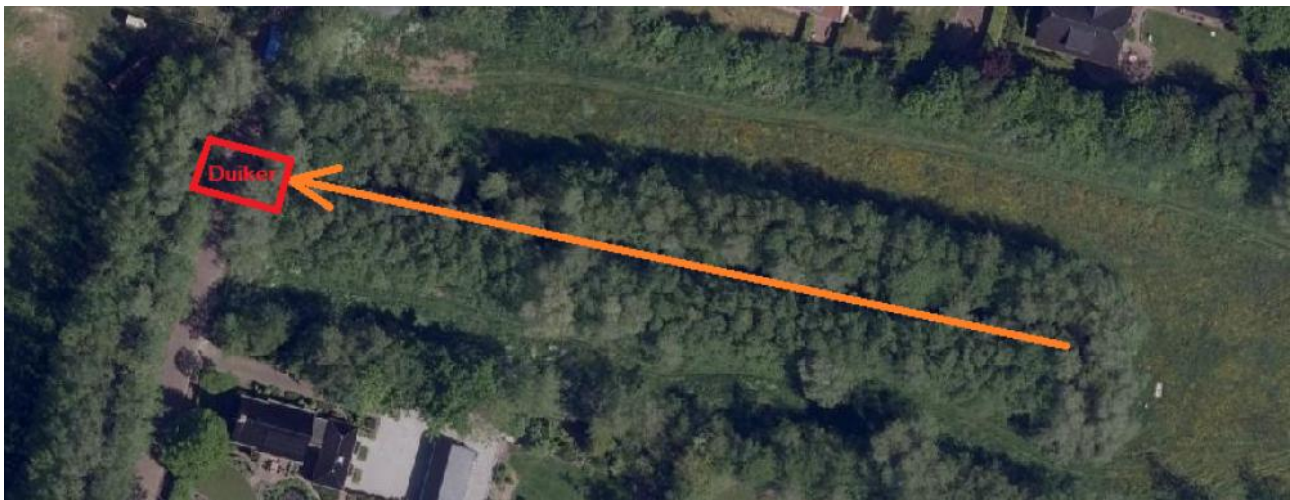
Afbeelding 3: De baggerwerkzaamheden moeten gestaag en in een oost-naar-westelijke richting worden uitgevoerd, om vissen en amfibieën naar de duiker onder de Lange Reed te drijven.
